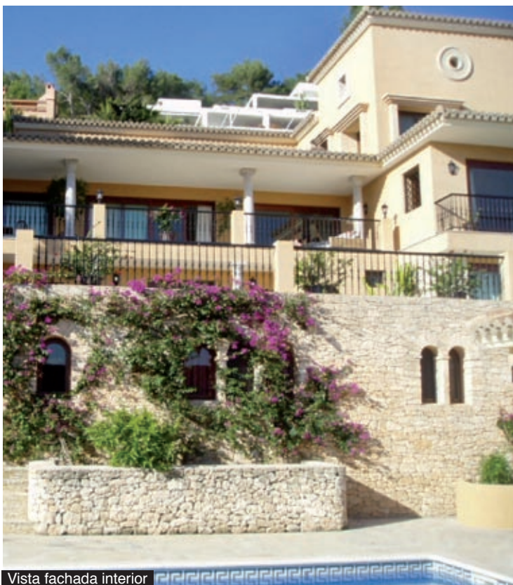
Vista fachada interior
